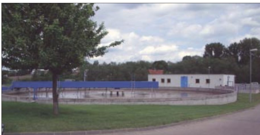
Kläranlage des Wasser- und Abwasserzweckverbandes Gotha und Landkreisgemeinden. Hier fallen jährlich etwa 6.000 Tonnen, nun zertifizierten, Klärschlamm an.
